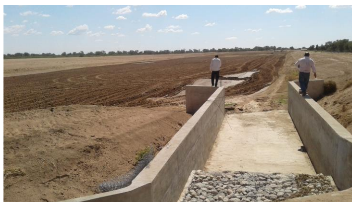
Detalle de la entrada a la represa de 3 ha, con el uso de gaviones como cámara disipadora de energía
