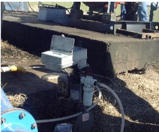
Equipo de fertirriego por un controlador **Star**, en este caso el productor alimenta varios lotes de riego desde una planta de bombeo de fertilizante. Este controlador funciona en paralelo con el que esta montado en la válvula **p&r**
